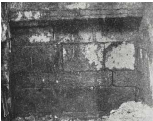
Figura 2. Instantánea de la excavación del vestíbulo del monumento con restos de enlucido en los sillares (López-Martí, 1927b).
